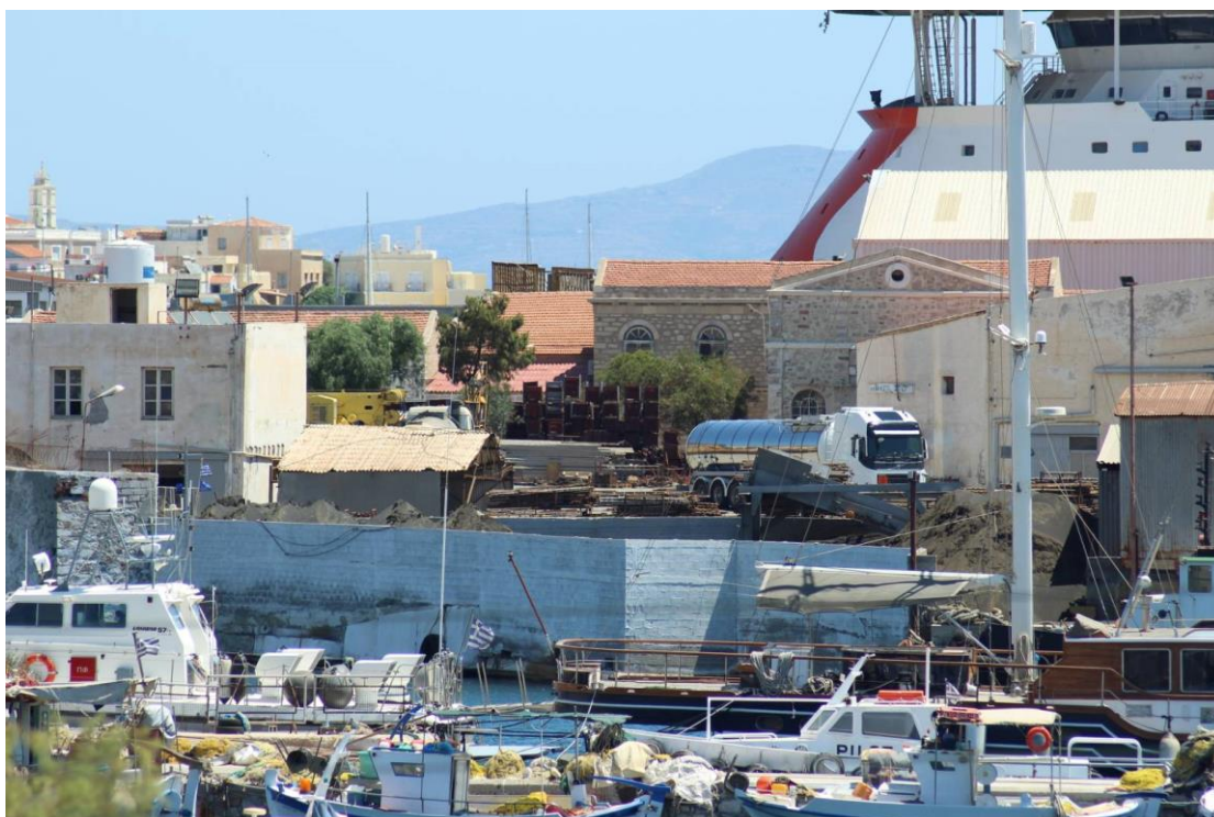
Φωτογραφία 3: Ημερομηνία λήψης 29/6/2021 – Η συσσωρευμένη αμμοβολή προεξέχει του τοιχείου του ναυπηγείου.
