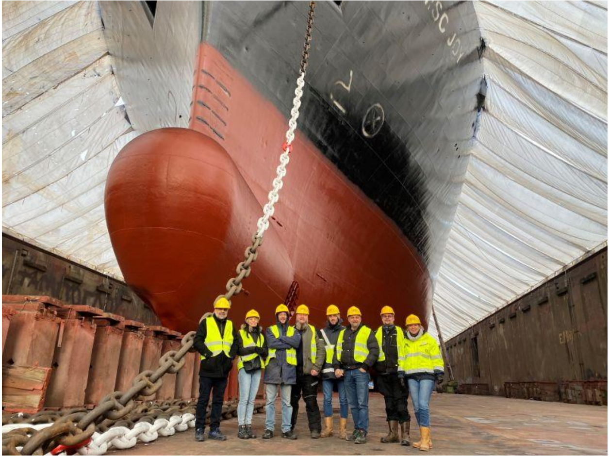
Ναυπηγείο Αμβέρσας (EDR Antwerp Shipyard) – προσωρινή κάλυψη του χώρου των εργασιών
